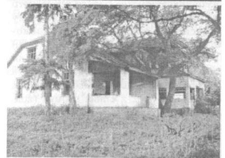
Івківці. Будинок Вахромєєва, 2006
